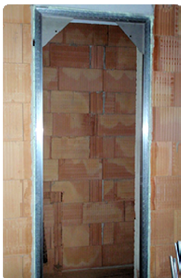
montáž skryté zárubně DURUS 45 A FORTIUS 52 do zdiva
