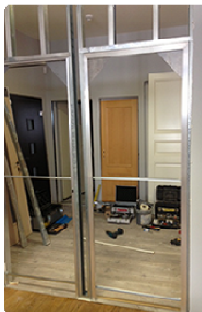
Obr.2 - montáž skryté zárubně DURUS 45 A FORTIUS 52 do sádrokartonové přičky
